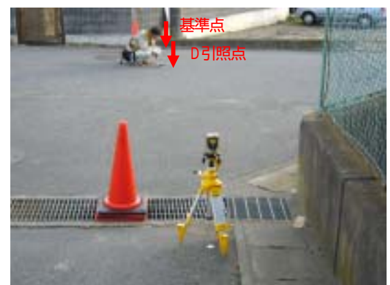
基準点埋設後の点検
