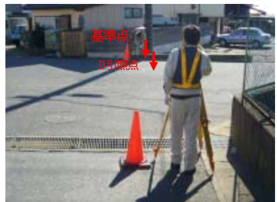
基準点埋設後の点検
