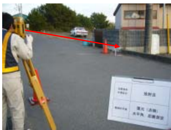
基準点埋設後の点検
