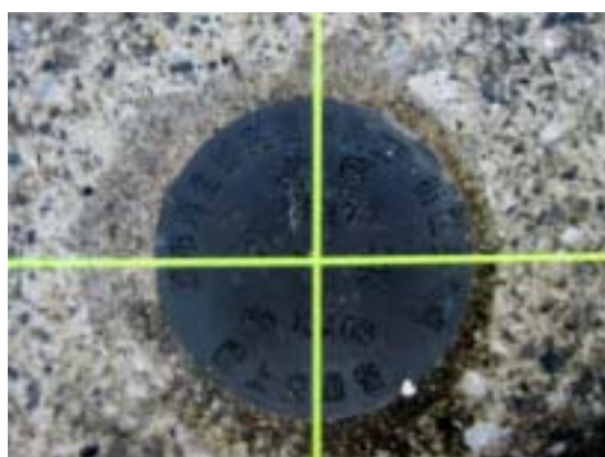
基準点埋設後の点検
