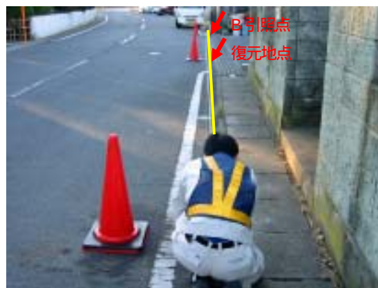
水系を張る(A引照点～復元地点～B引照点)
