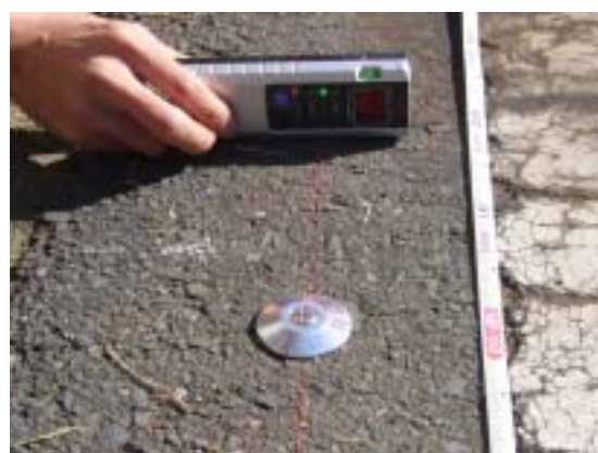
引照点設置後の点検
