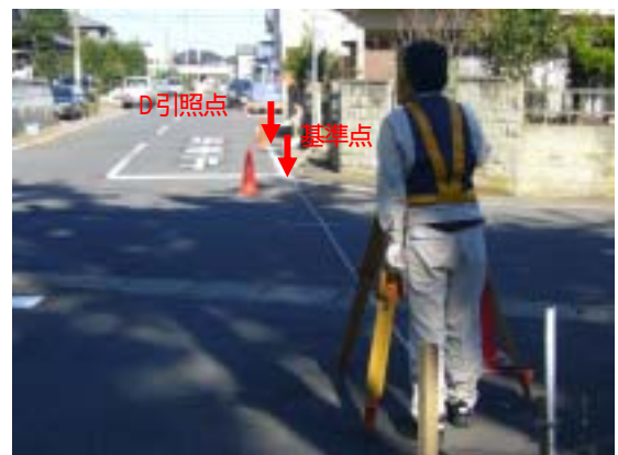
基準点埋設後の点検
