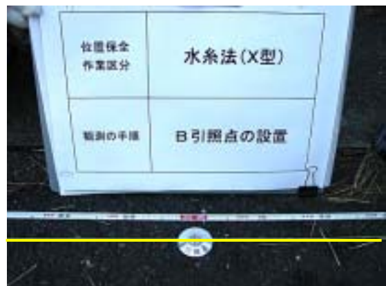
引照点設置後の点検
