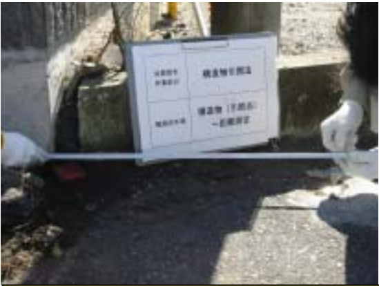
基準点埋設後の点検
