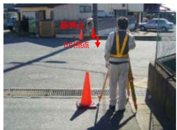
基準点埋設後の点検
