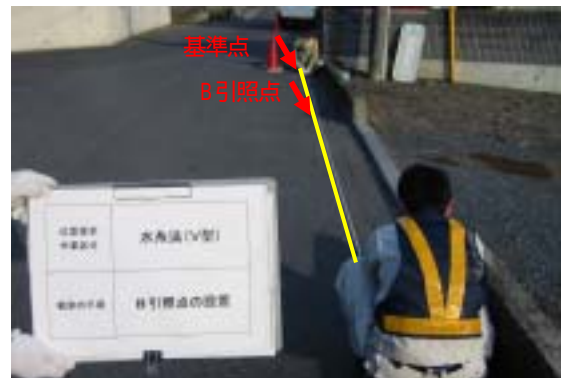
水系を張る(A引照点～B引照点～基準点)
