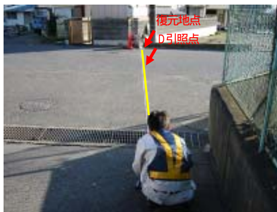
水系を張る(C引照点～D引照点～復元地点)
