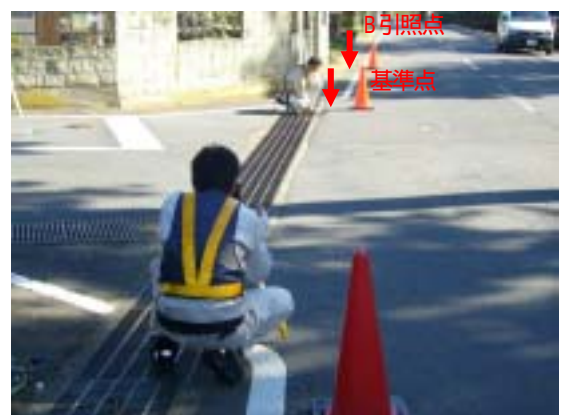
基準点埋設後の点検
